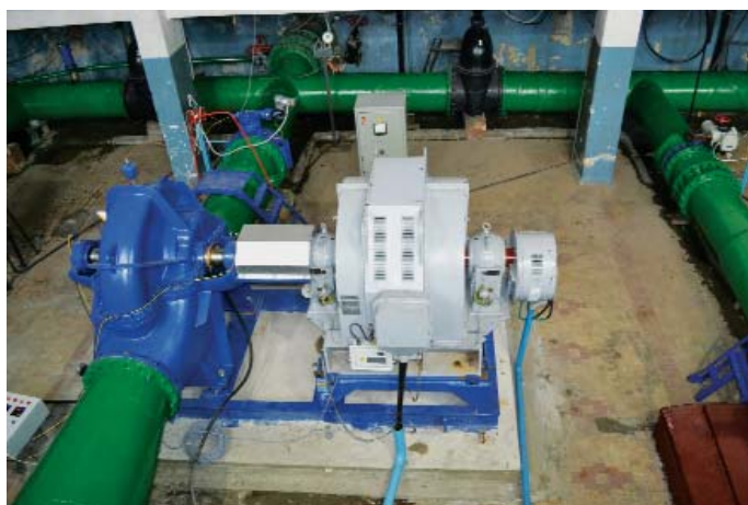
Насос с электродвигателем для работы с преобразователем частоты
