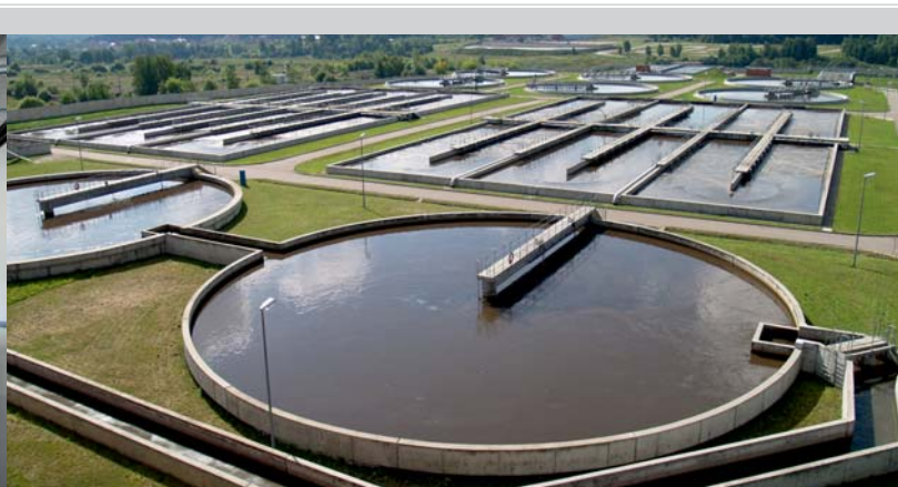
Очистные сооружения канализации
