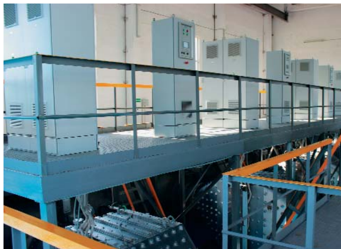
Станция очистки ультрафиолетом
