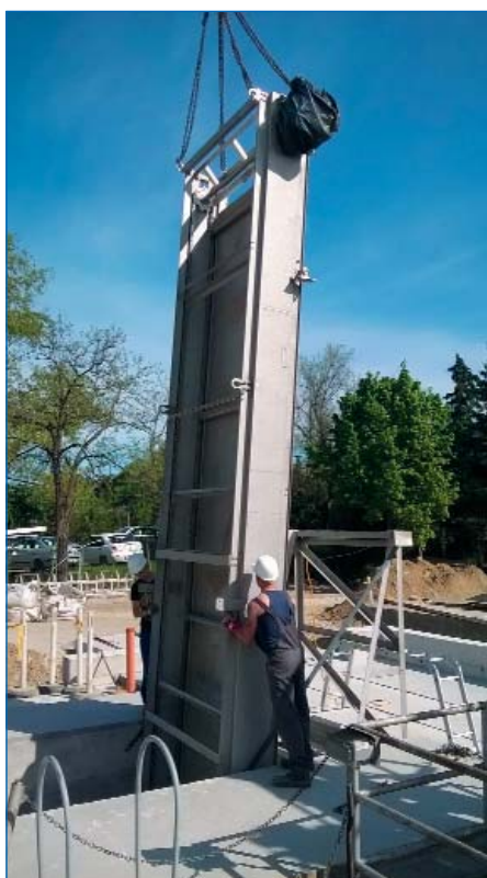
■ Рис. 9. Монтаж грабельной решетки РКЭ высотой 11,5 м
