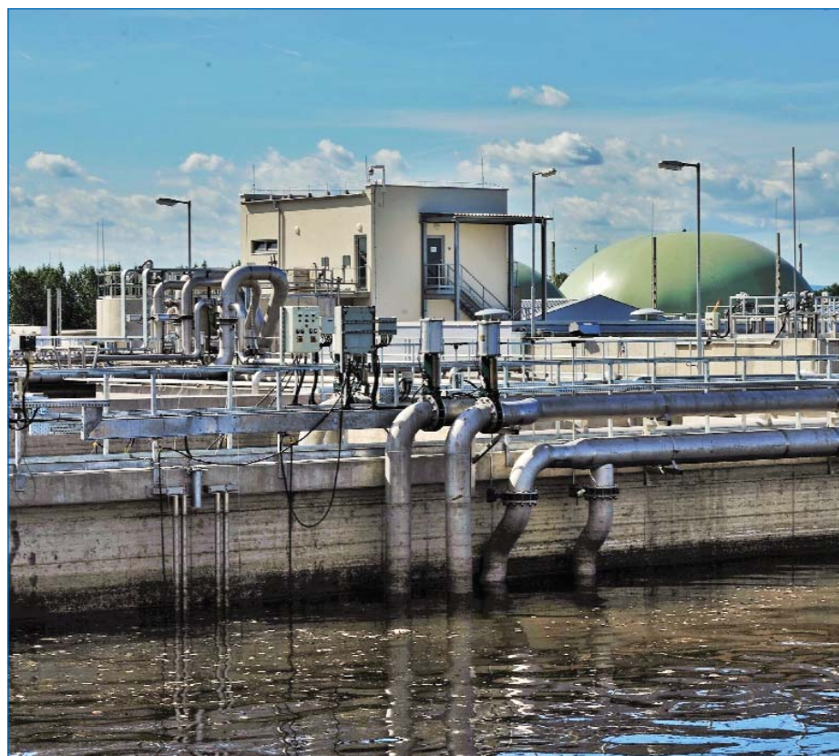
■ Рис. 10. Очистные сооружения г. Шиофок, 2016 г
