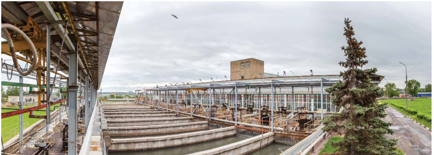
Песколовки. Люберецкие очистные сооружения
