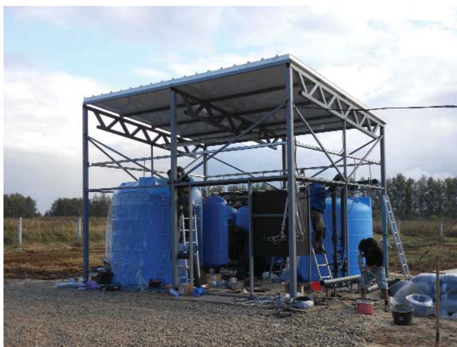
Завершающая стадия монтажа оборудования станции очистки воды в д.Турлатово Рязанского района Рязанской области
