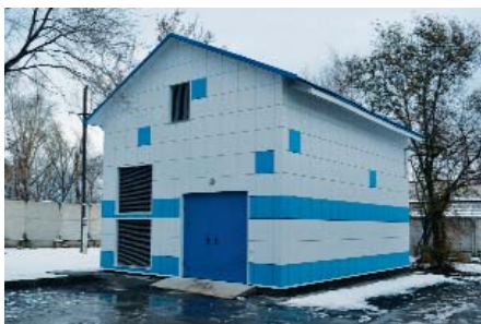
Станция частотного управления
