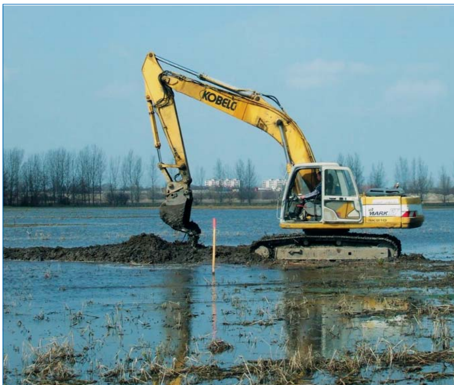
■ Рис. 3. Начало строительства очистных сооружений
