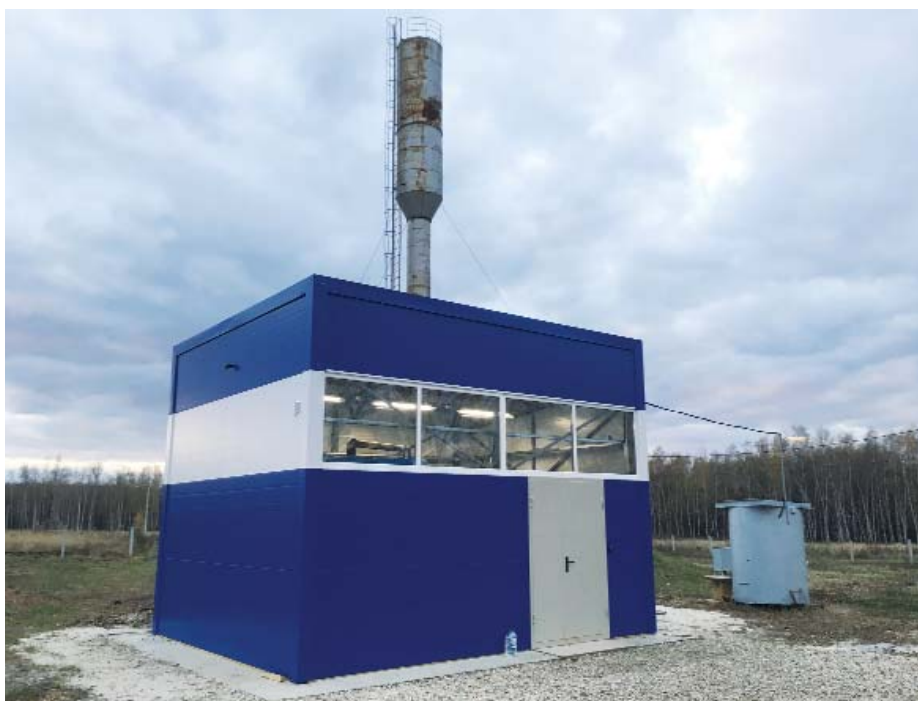
Озono-кислородная станция очистки воды в д. Турлатово Рязанского района Рязанской области
