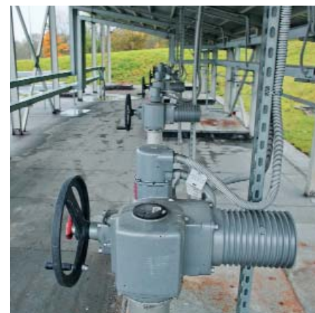
Запорная арматура с электроприводом на ОСПС в пос. Осиновая роща
