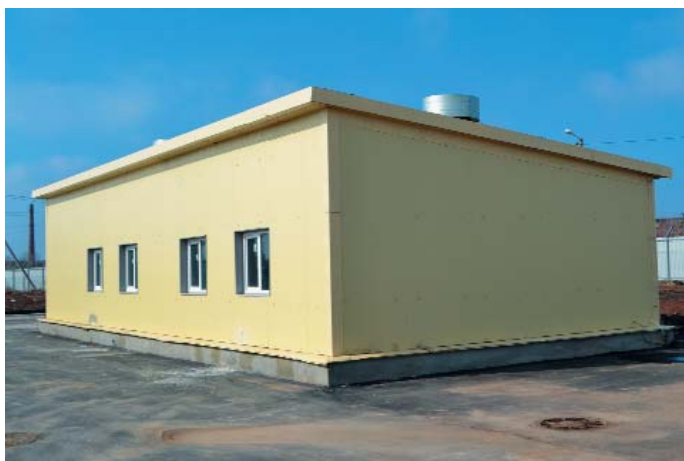
Здание насосной станции II подъема
