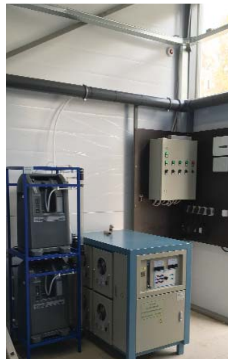
Блок управления работой станции
