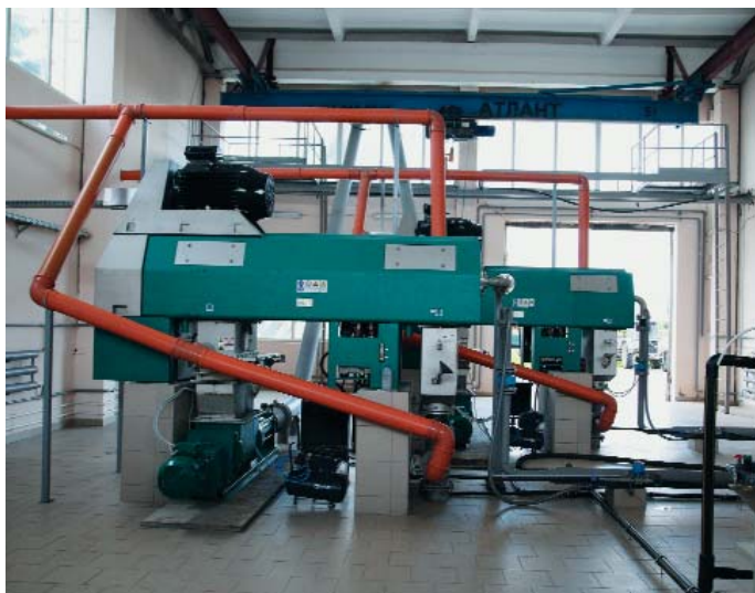
Цех механического обезвоживания осадка
