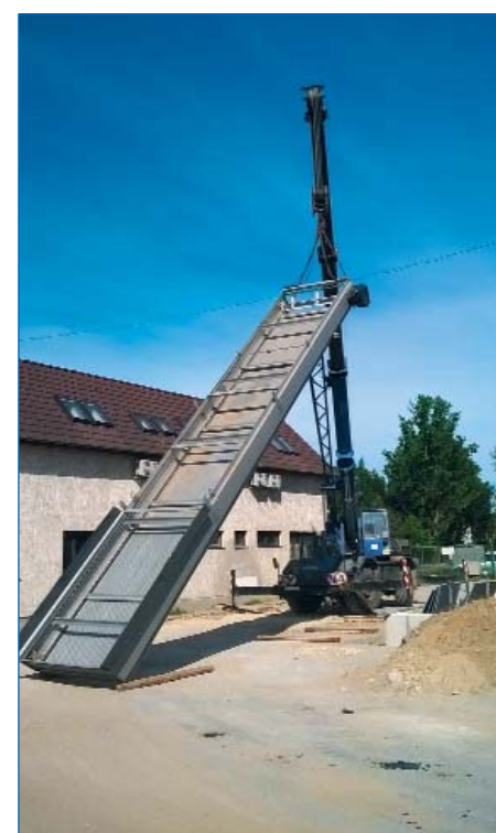
■ Рис. 4. Монтаж граблевой решетки РКЭ на очистных сооружениях
