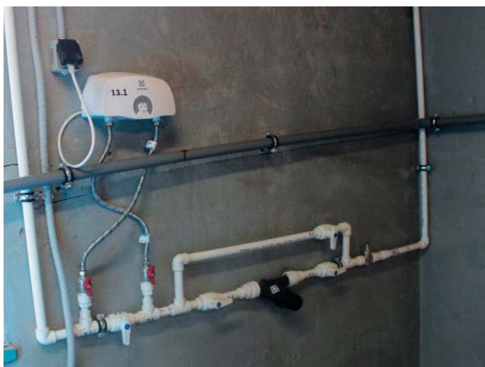
Узел водоподготовки станции
