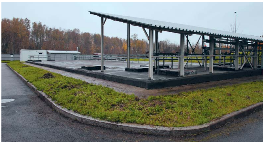
Очистные сооружения поверхностного стока в подземном исполнении
