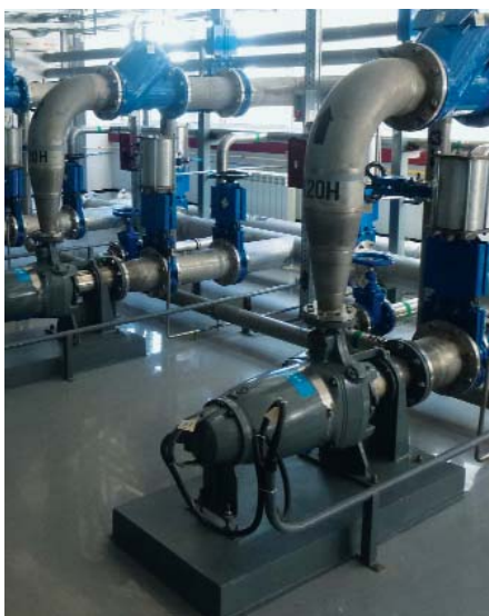
Погружной насос Flygt NZ 3153.091 HT в сухой горизонтальной установке
