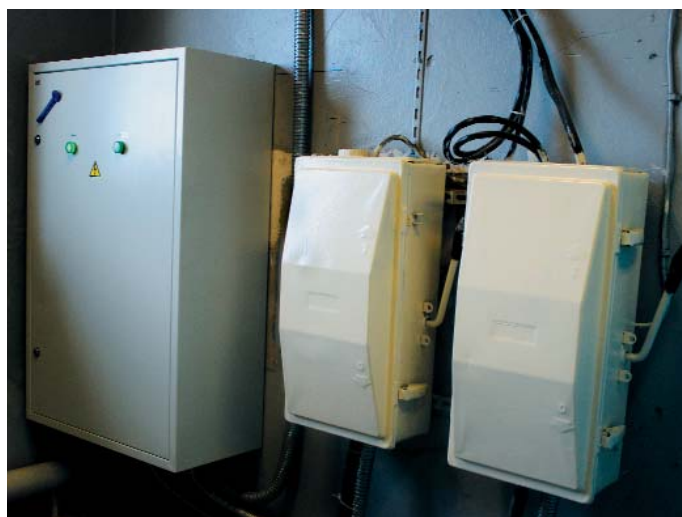
Блок управления станции
