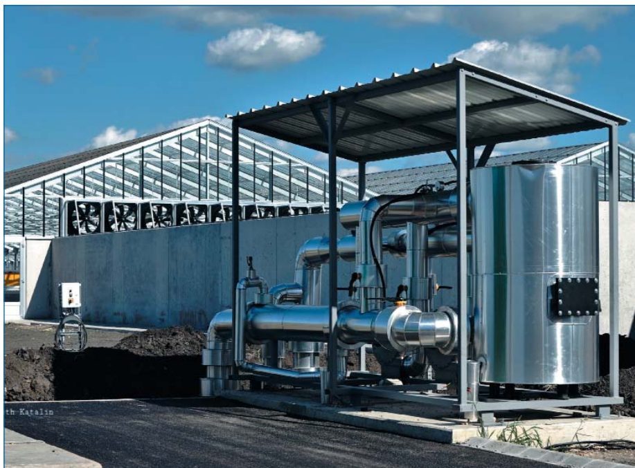
■ Рис. 2. Очистные сооружения г. Шиофок. Общий вид
