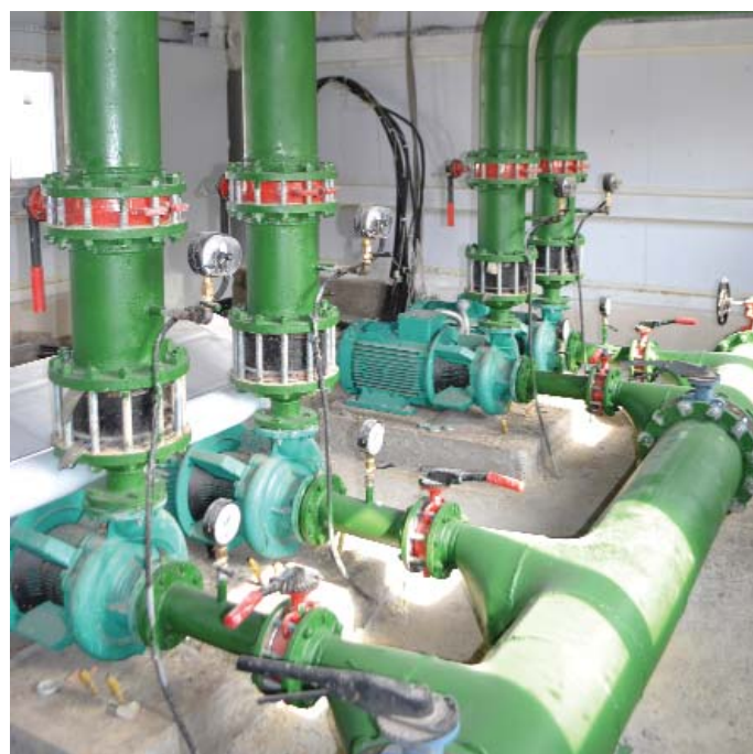
Группа насосов в насосной станции 2 подъема
