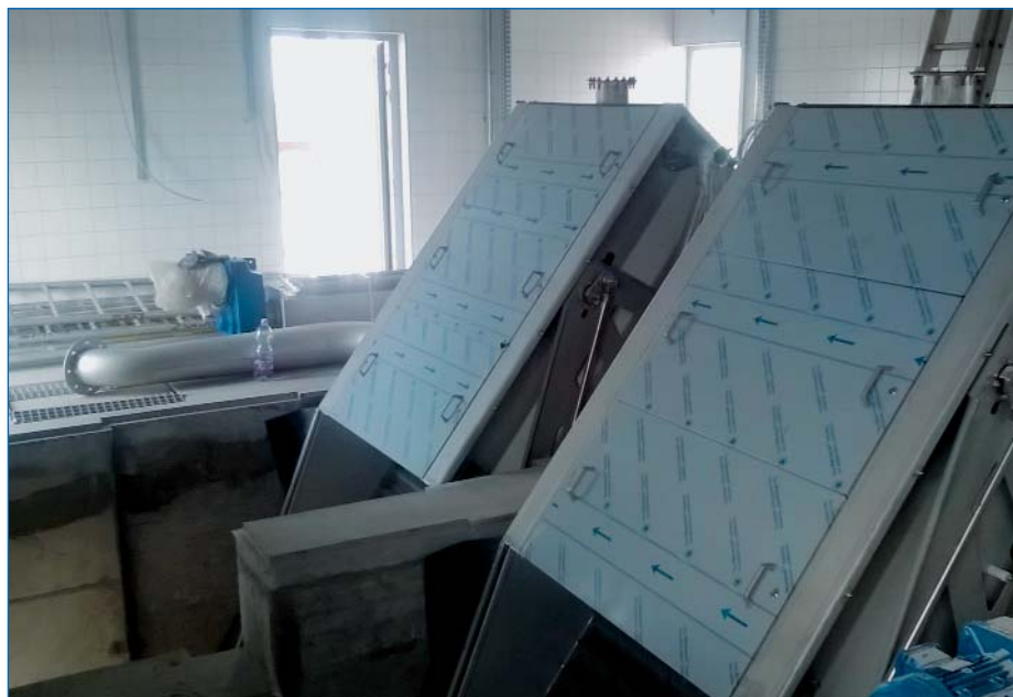
■ Рис. 6. Ступенчатые решетки РСК
