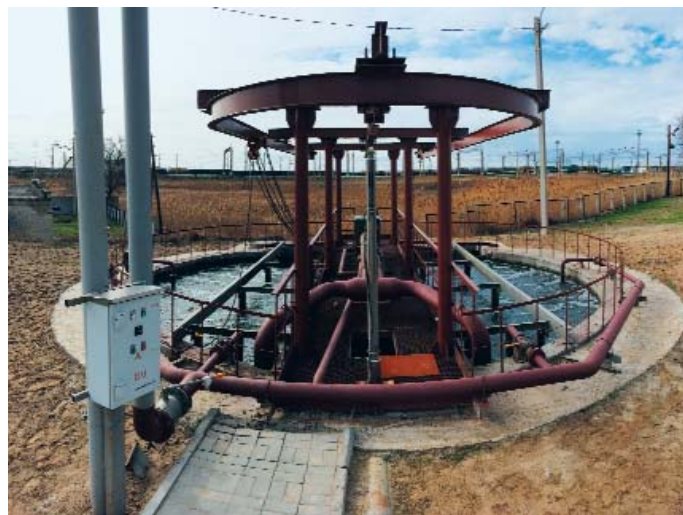
Аэротенк нитри-денитрификатор №1
