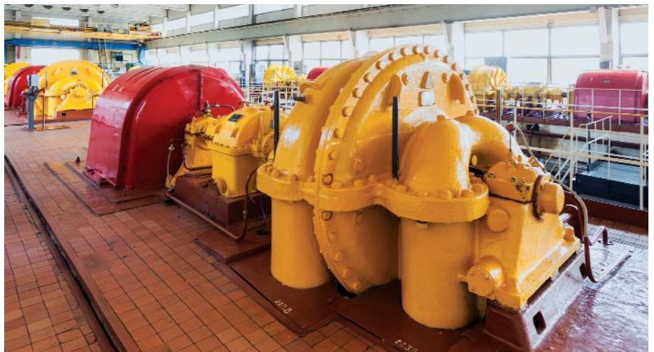
Зал воздуходувок. Курьяновские очистные сооружения
